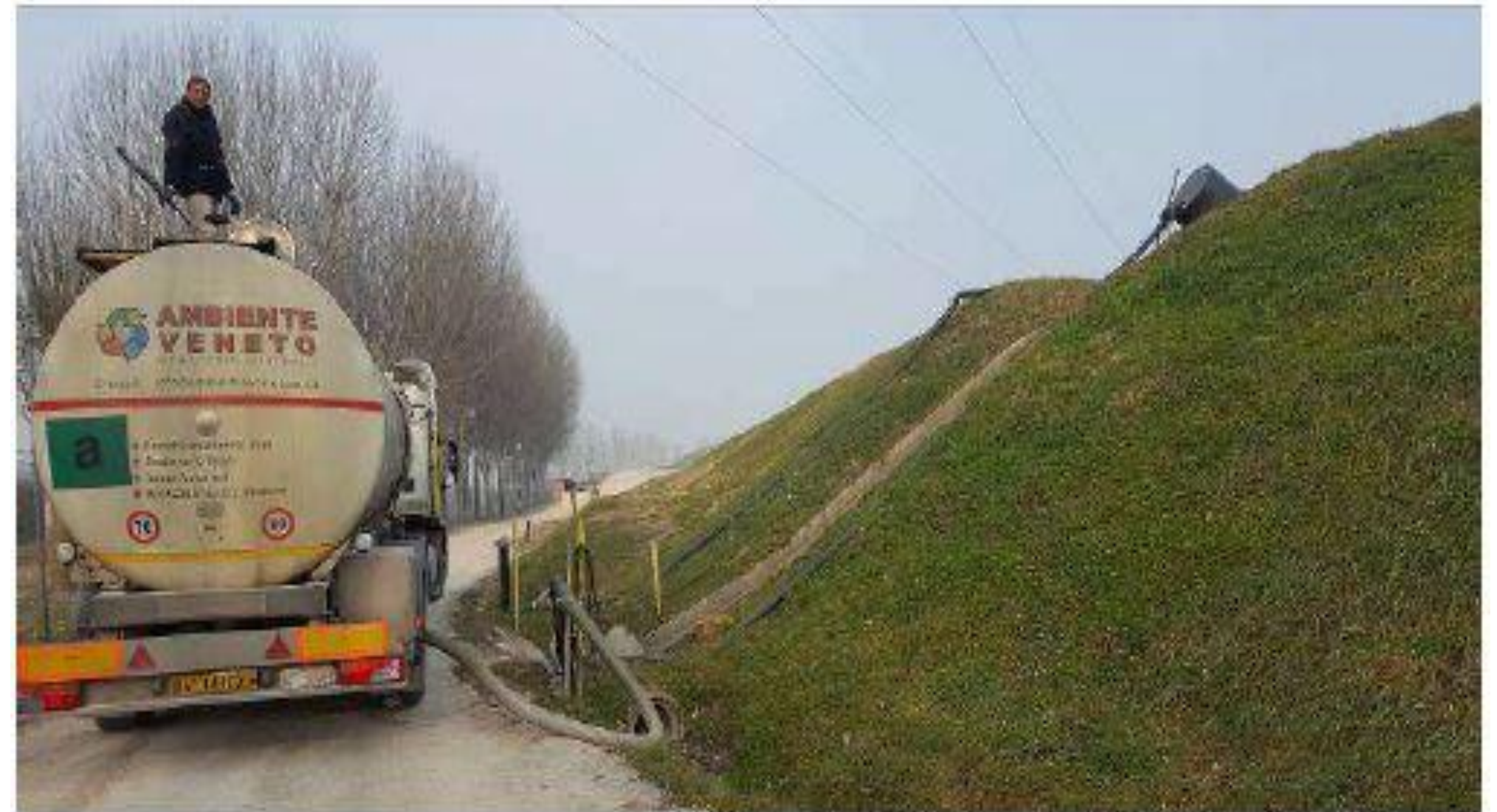
Figura 5: operazioni di asporto percolato (30/01/2017)
